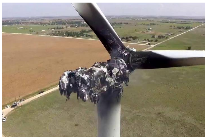
Figura 3-13 - Incêndio em uma torre eólica.
