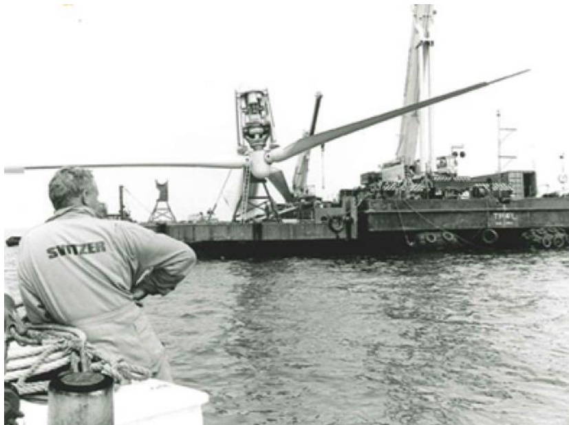
Figura 5-1 - Primeiras Turbinas OffShore instaladas na Dinamarca -Total de 11 turbinas de 450kW cada.
